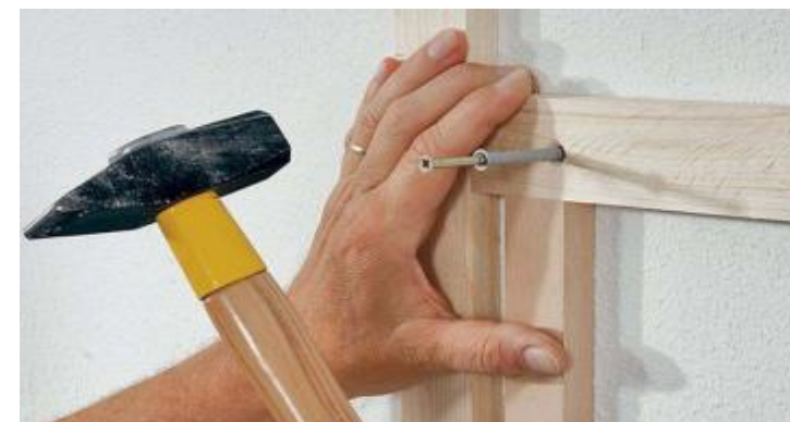
Основной крепежный элемент действует по принципу гвоздя, а не шурупа
